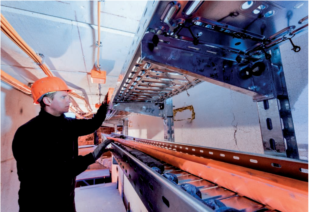
Prüfaufbau einer Funktionserhalt-Kabelanlage
