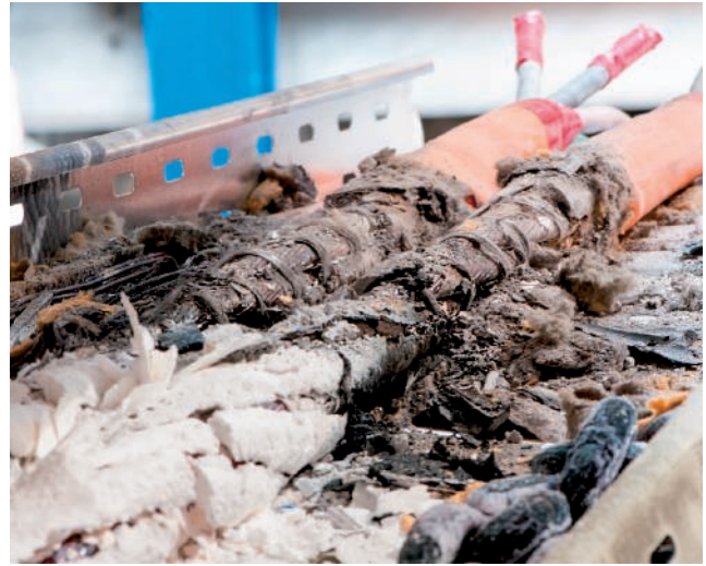
...und nach der Brandprüfung
