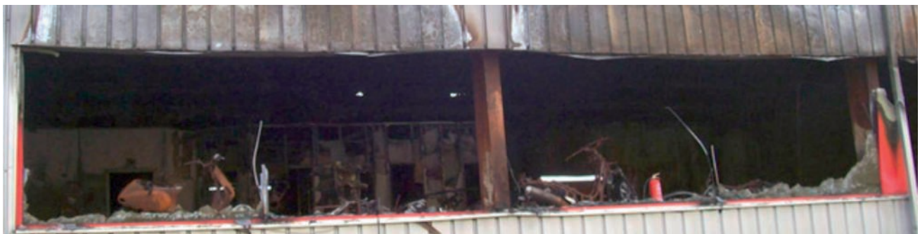
Brandschaden durch korrosive Gase
