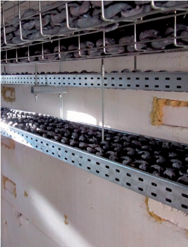
Kabelrinne mit hoher mechanischer Last vor...
