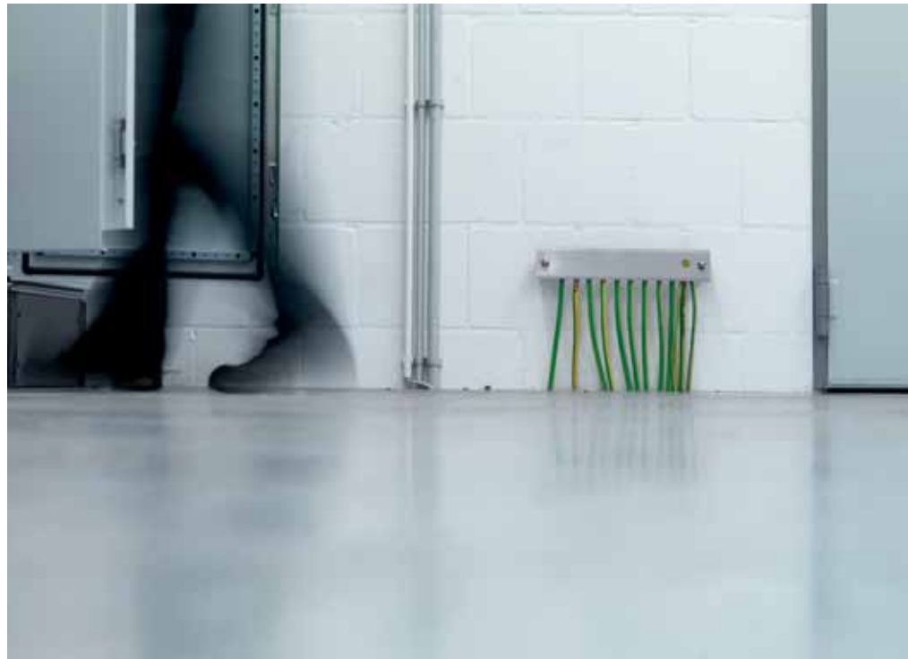
oben: Fangeinrichtung an reetgedecktem Haus mit grauer isCon®-Leitung unten: Potentialausgleichsschiene
