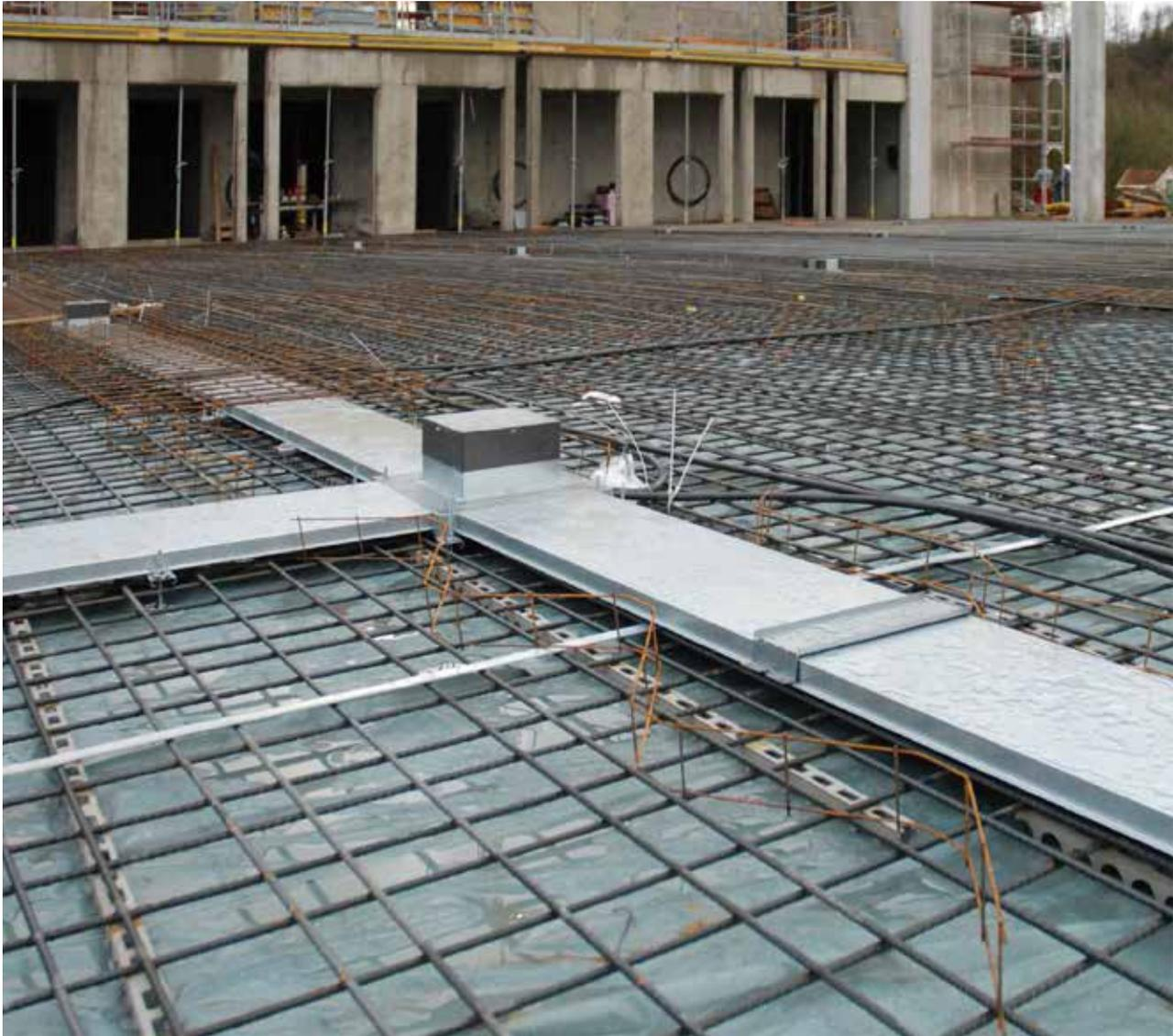
Montagefreundlichkeit, Robustheit und eine perfekte Einbindung in das Gebäude - das alles bietet das Im-Beton-Kanalsystem. Es ist abgestimmt auf neueste Entwicklungen und Trends in der Bauwirtschaft - auf die Technologie der Betonkernaktivierung genauso wie auf aktuelle Brandschutzrichtlinien.
