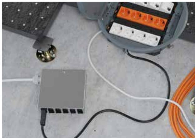
Die Steckanschlüsse an den Modul 45connect®-Steckdosen befinden sich unterhalb der Anschlusseinheit. Dies ermöglicht die Steckverbindung außerhalb des Bodentanks vorzunehmen. Der Einbau des angeschlossenen Universalträgers in den Bodentank erfolgt durch Absenken in der Rastleier. Die Befestigung im Bodentank erfolgt über die Drehriegel in der Rastleier.
