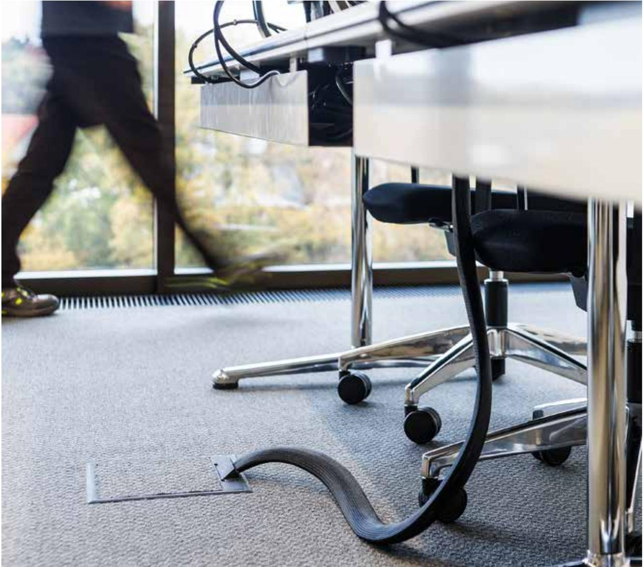
Geräteeinsätze versorgen Arbeitsplätze und andere Punkte mitten im Raum über den Boden mit Strom- und Datenanschlüssen. Es gibt Ausführungen für trocken und für nass gepflegte Böden, in runder und in eckiger Bauform. Als Materialien kommen Kunststoff oder Metall zum Einsatz.
