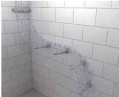
Steigende und fallende Bögen Durch Einschnitte in jede zweite Masche der Gitterrinnenkante und entsprechendes Biegen lassen sich steigende und fallende Vertikalbögen herstellen.
