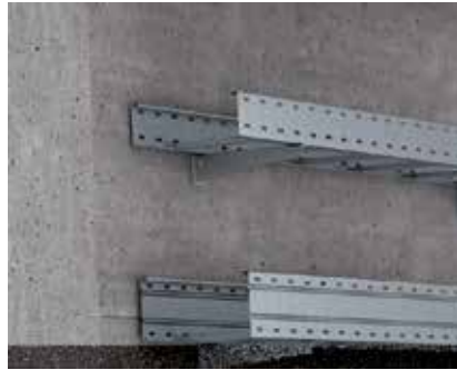
Anwendung Wandmontage Direkte Wandmontage von Weitspannsystemen.
