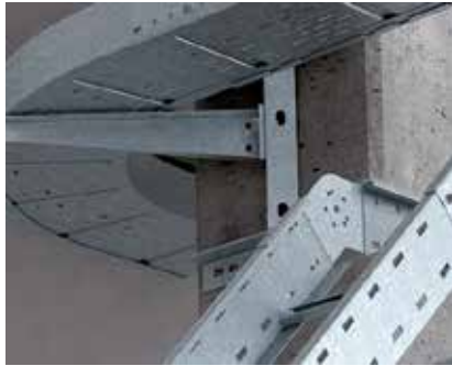
Anwendung Weitspannformteile Montagebeispiele für horizontale und vertikale Richtungsänderungen bei Weitspannsystemen.
