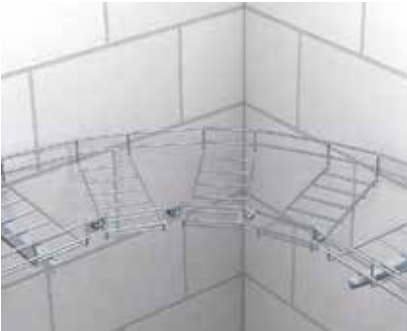
Herstellung eines Gitterrinnenbogens - rund Durch Ausschneiden jeder zweiten Masche einer Gitterrinne können Gitterrinnenbögen mit größerem Radius hergestellt werden. Die Fixierung erfolgt mit Eckverbindern Typ GEV 36.
